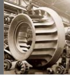
Rotores de turbina Francis
