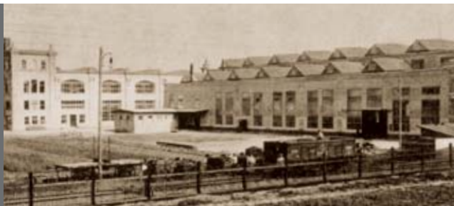
Fábrica de máquinas e fundição da filial em St. Poelten, 1904
