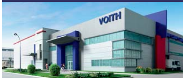
Fábrica da Voith Fabrics, em Kunshan, China
