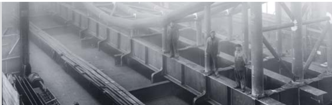
Reparo pela Voith, em 1946, de ponte em Neckargemuend, destruída durante a guerra
